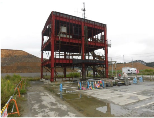
宮城県・南三陸町防災庁舎 2015年9月
